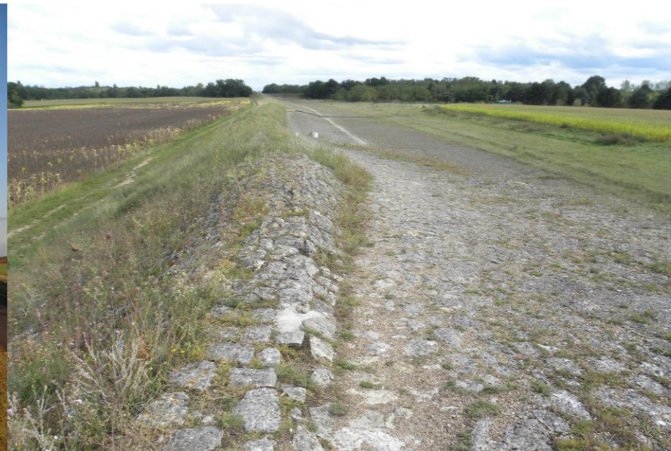
↑ Le déversoir de Jargeau permet l'inondation contrôlée du Val
