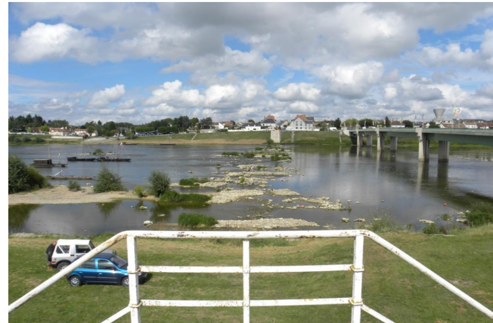
↑ Traces du pont historique entre Jargeau et St-Denis-de-l'Hôtel visibles dans le lit de la Loire
