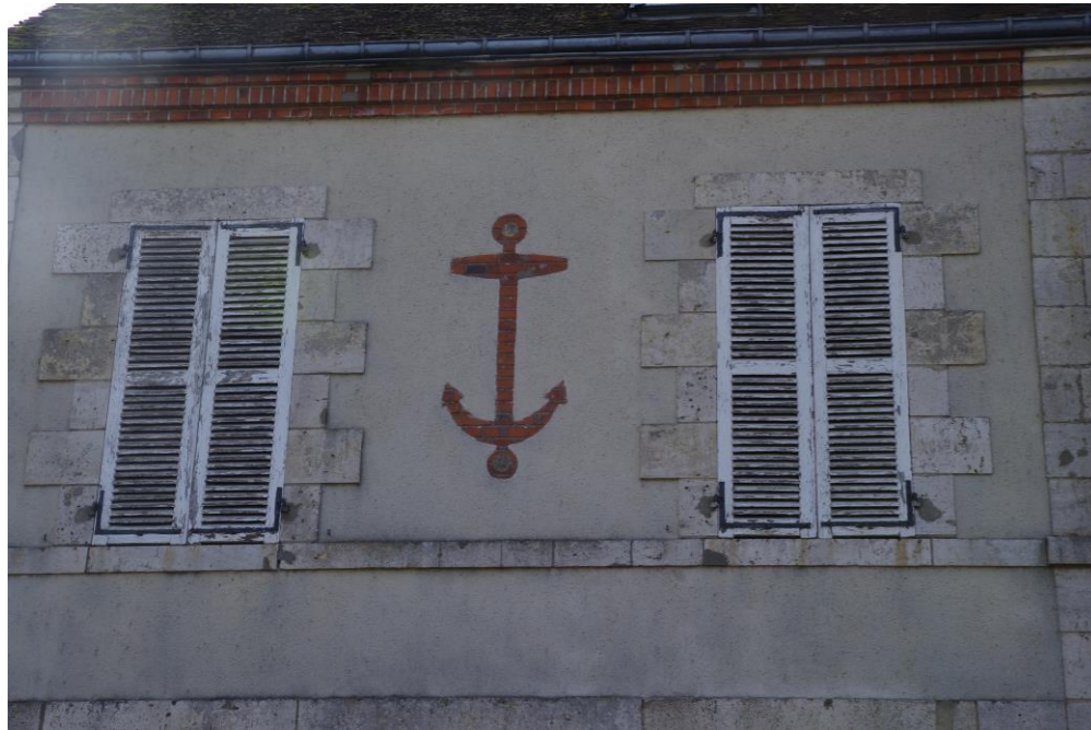
Encadrement en calcaire de Beauce, corniche et ornement en brique de Sologne sur une maison de marinier à Sully-sur-Loire
