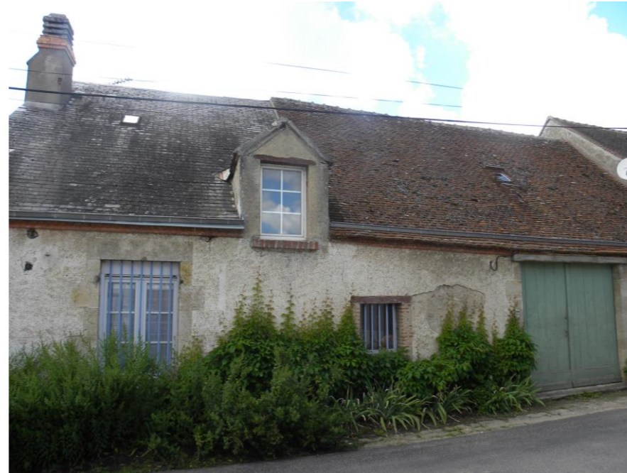
Toiture en ardoise et en tuile plate, modénatures et corniches en briques de Sologne, encadrement en calcaire de Beauce à Bou
