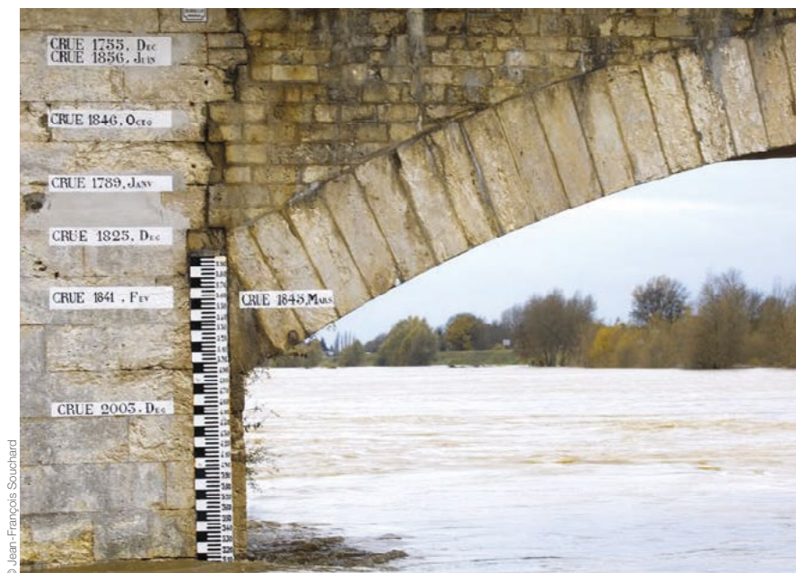
Echelles de crue sur le pont Général Leclerc à Amboise
