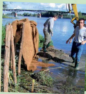
Blois (41), le confortement du pied de levée par des techniques de génie végétal.
