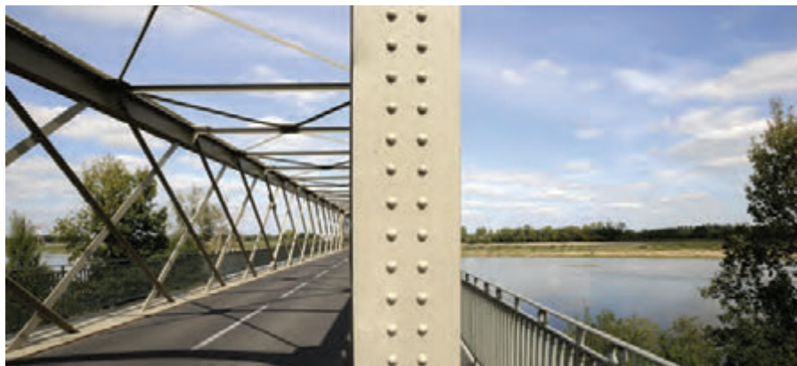
Pont de Montsoreau. Détail des rivets.
