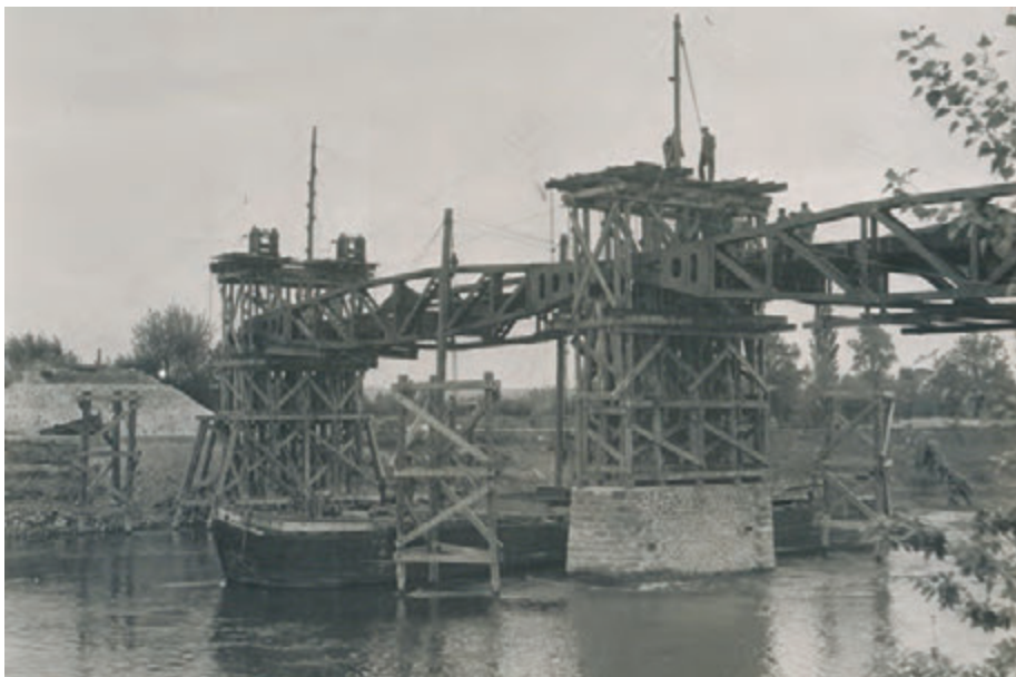
Béhuard-Savennières, le pont de la Guillemette, mise en place du système dit « Arromanche » en 1946. AOADRD, BERP 2, 96.
