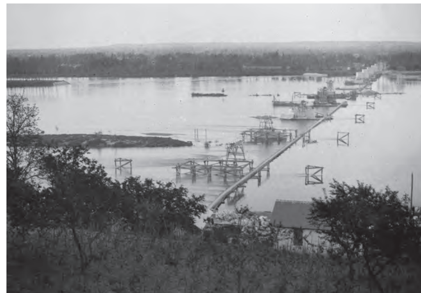
Le pont ferroviaire de Saumur en construction, photographie attribuée à Victor Coué, vers 1882-1886. AM Saumur, 34 Fi 169.
