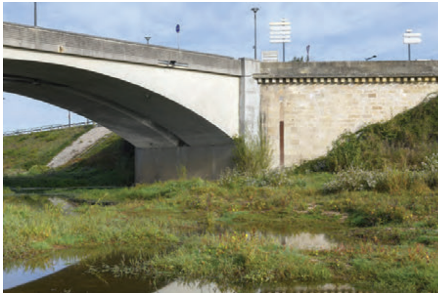
Culée nord du pont des Cadets de Saumur. Le parement en pierre du xix e siècle a été conservé.
