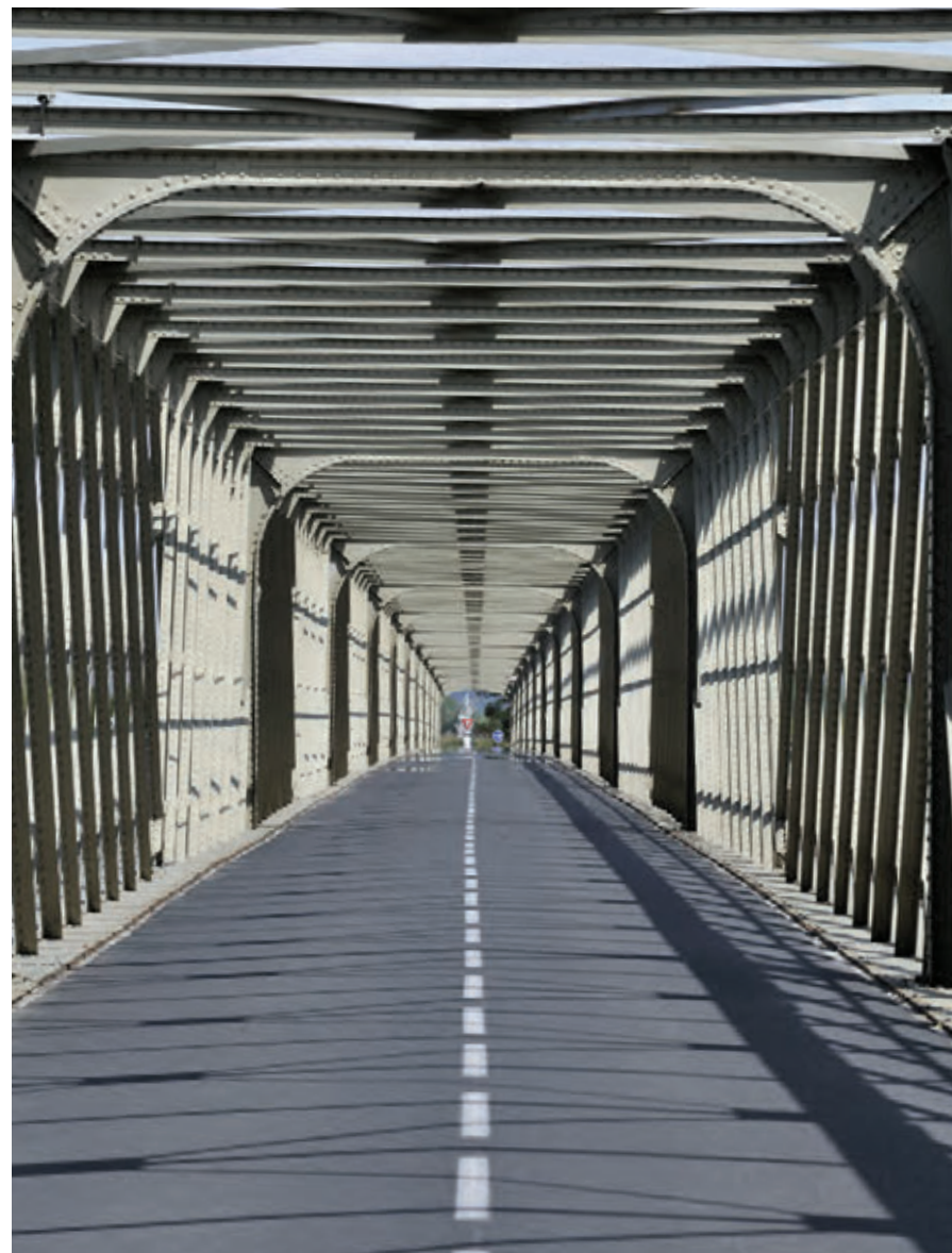
Pont de Montsoreau. Vue du tablier et de la cage.
