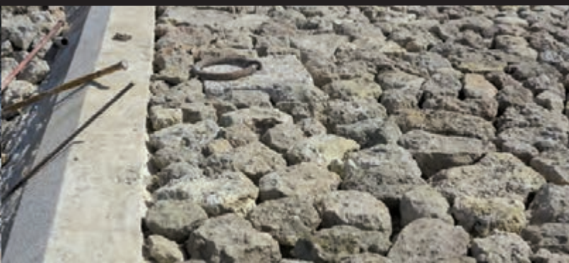
Rampe en moellons de pierre de champ avant rejointoiement.
