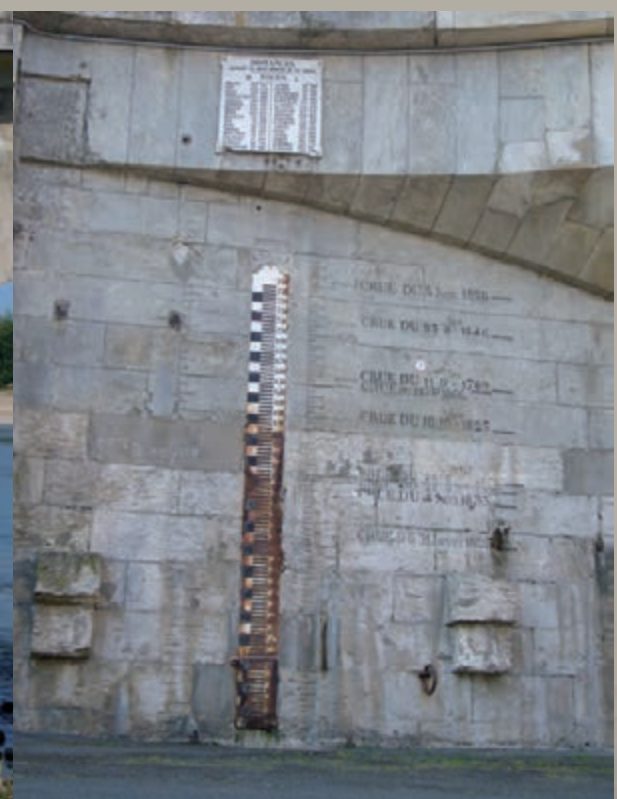
A Tours, rive gauche, marques de crues, échelle hydrométrique et plaque de distances sur la culée du pont Wilson.
