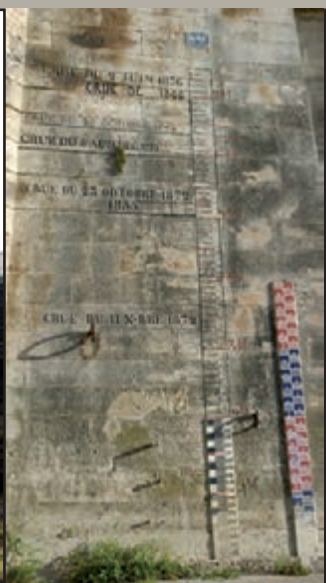
Echelles de crues, marques de crues et organeaux sur l'aculée du pont Georges V, rive droite.
