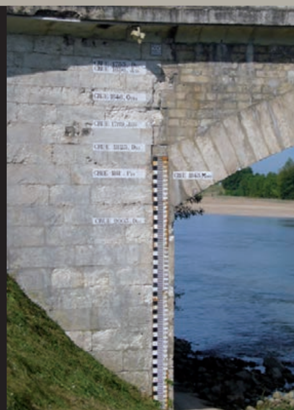
Echelle hydrométrique du Port Vieil à Blois. Echelle hydrométrique placée sur l'une des culées du pont d'Amboise, côté rive droite de l'île d'Or. Avec des repères de crue, de 1755 à 2003 !
