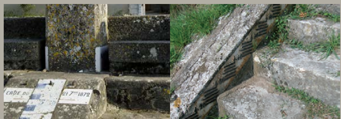
A Chaumont-sur-Loire, une échelle hydrométrique est fixée sur un escalier et, une fois en haut de la levée, se poursuit de l'autre côté de la route sur la maison d'en face, avec des repères de crues.
