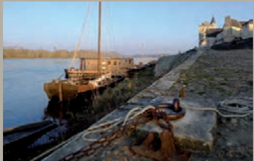
Un organeau toujours en usage sur le port de Montsoreau (MVL).
