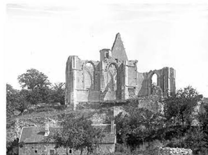
Photographie par Louis Bousrez en 1896 des ruines de la collégiale des Roches Tranchelion à Avon-les-Roches (Indre-et-Loire). 0104 0041.
