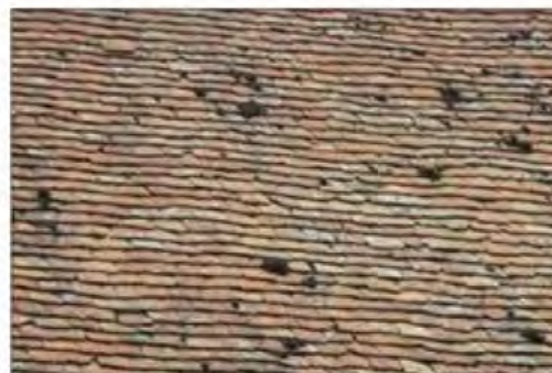
Couverture en petites tuiles plates
