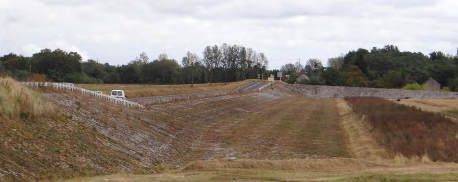
Le déversoir de Montlivault
