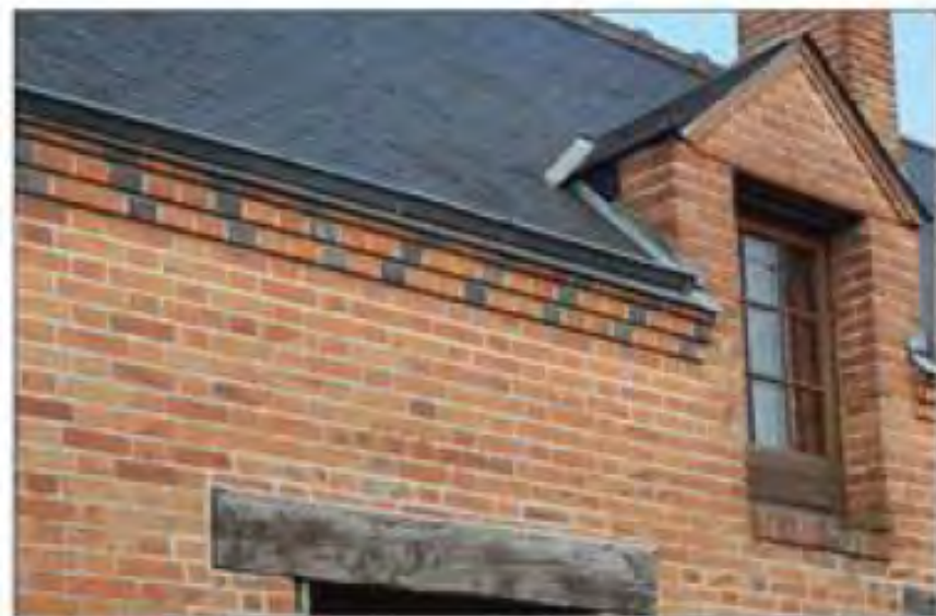
Maçonnerie de brique
