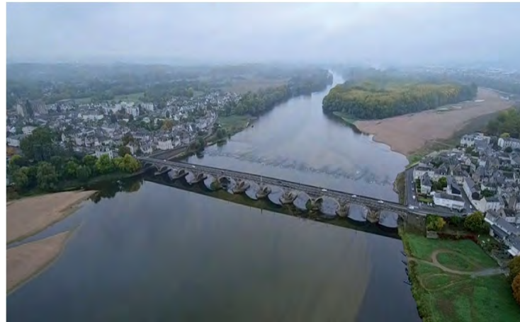
Pont Dumnacus aux Ponts-de-Cé
