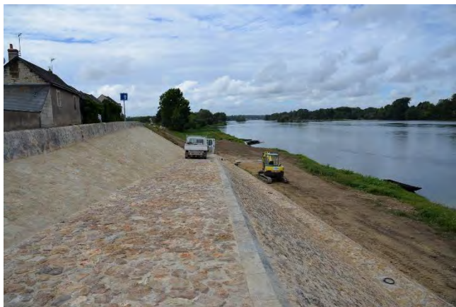
Savigny-en-Véron, restauration de la cale de Bertignolles
