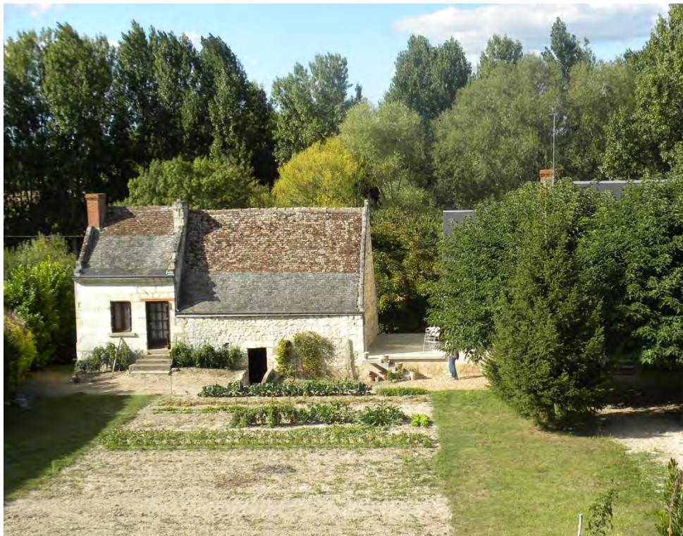
Huismes, ardoises, tuiles et tuffeau
